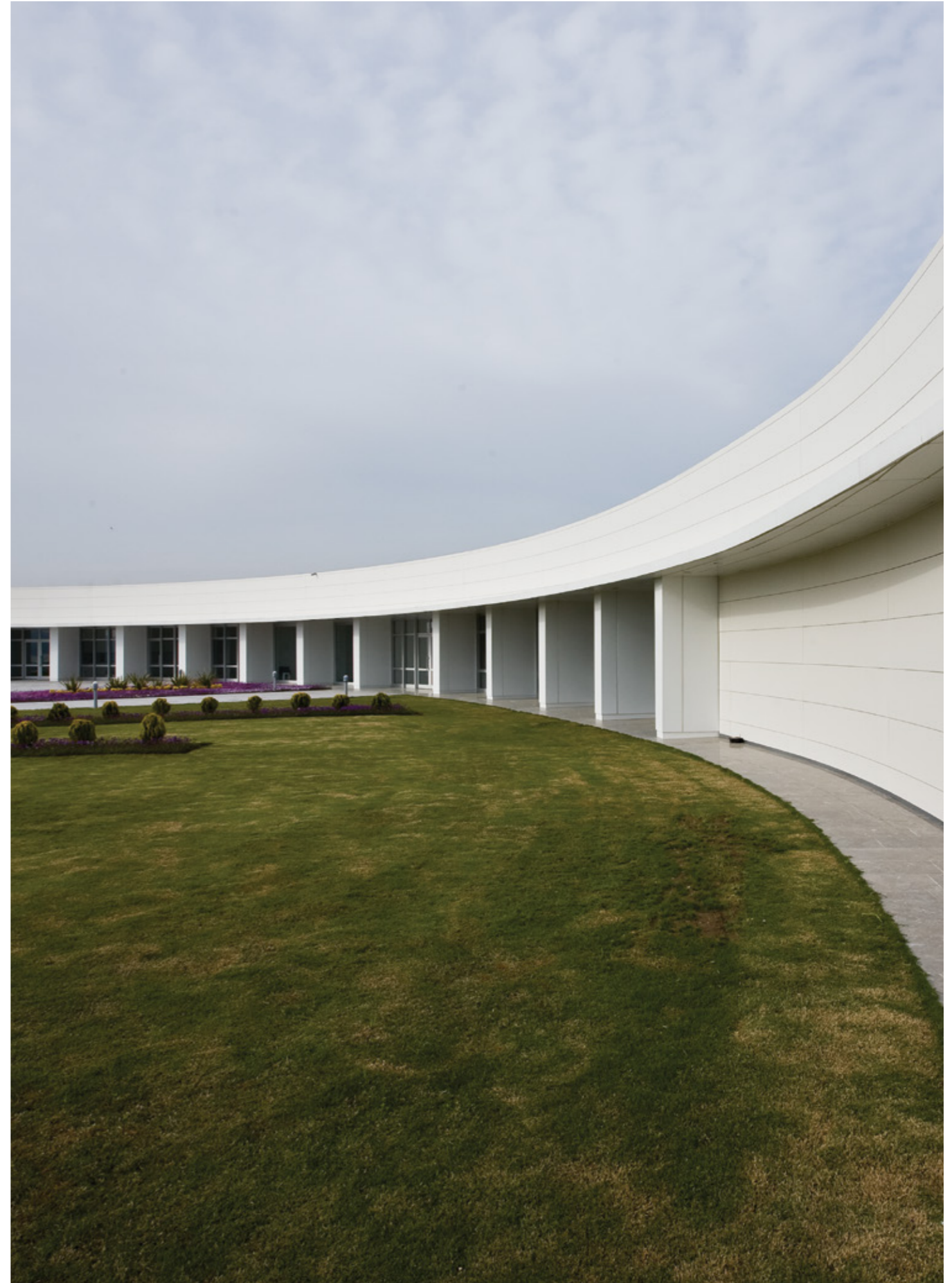
İTOB Administration Building, Menderes / İzmir İTOB Yönetim Binası, Menderes / İzmir
